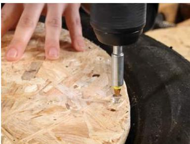
**4.** Je eine der Platten oben und unten mit 14 der Schrauben am Reifen befestigen.
